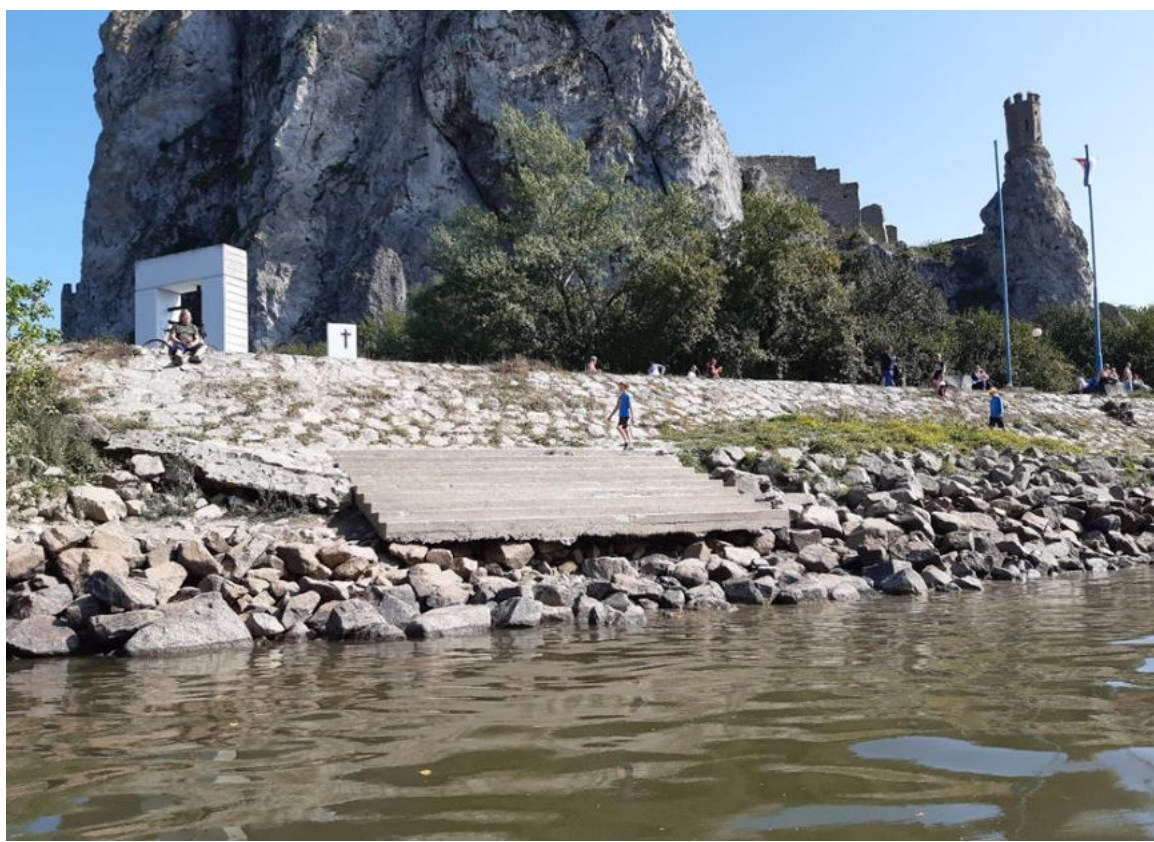
Obr.č.11. Devín, schody pre nastupovanie a vystupovanie vodákov na brehu Moravy, ktoré nie sú správne výškovo umiestnené, funkčné a použiteľné pri nižších vodných hladinách.
