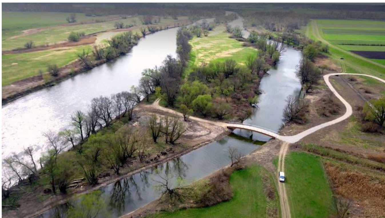
Obr. č. 3. Pohľad na Moravu a bočné rameno Alter Zipf zo severu na miesto kde bolo rameno sprietočnené a následne bol na mieste vybudovaný most pre peších a cyklistov.
