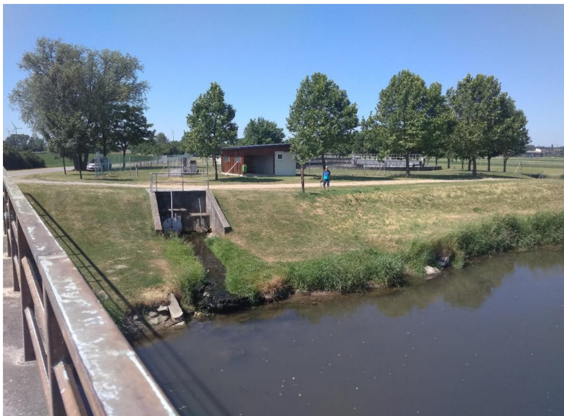
Obr.č. 93. Nickelsdorf - pozemok sa nachádza v extraviláne obce a v jeho susedstve sa nachádza technická infraštruktúra obce.
