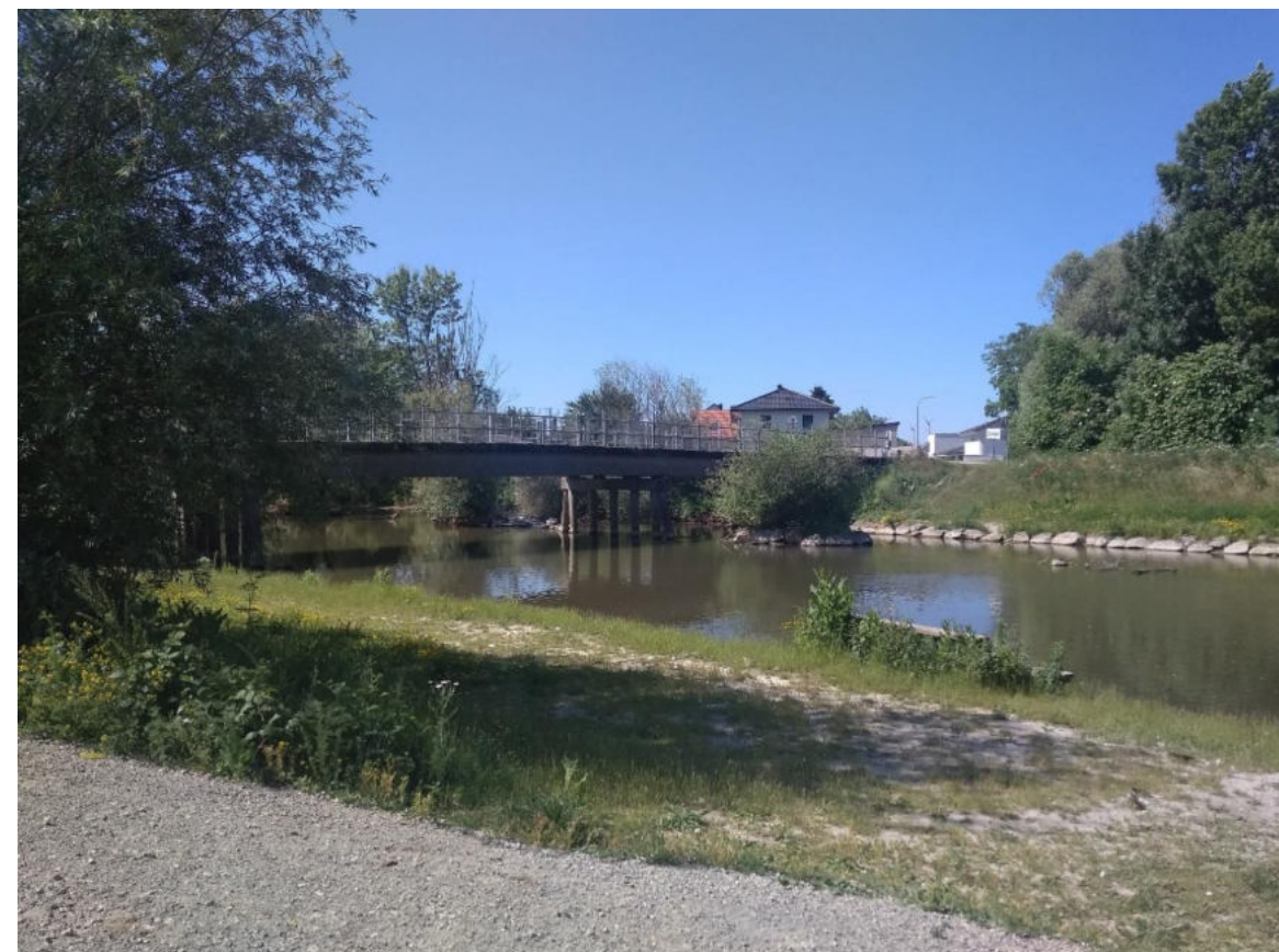
Obr.č. 90. Zurndorf - pohľad na riešený pozemok, ktorý je pre svoju miernu svahovitosť vhodným miestom na nástup s kanoe.
