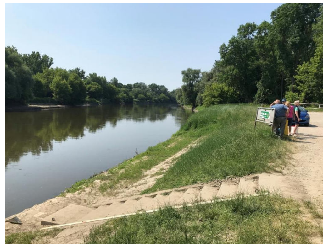
Obr. č. 35. Jestvujúce schodíky k rieke Morave v správe Via Donau v katastri obce Dürnkrut.
