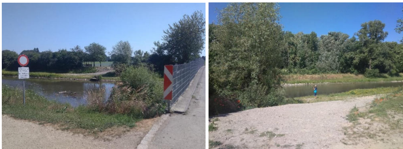
Obr.č. 88. a 89. Pohľad na pozemok situovaný na ľavom brehu rieky poskytujúci ideálne podmienky pre vybudovanie prístaviska.
