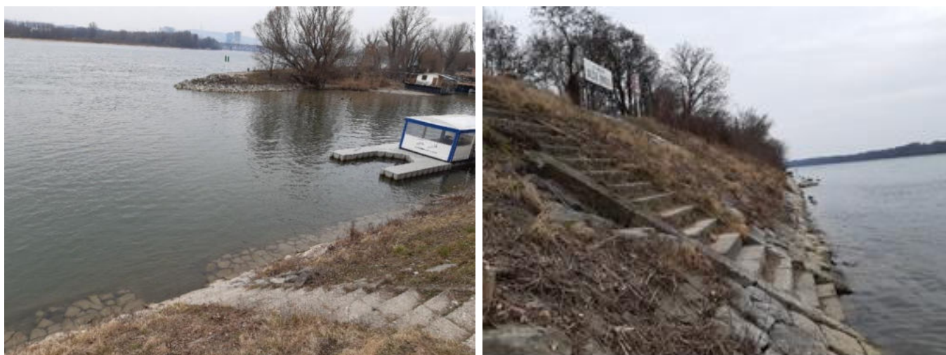
Obr.č.57. a 58. Pohľad na vstup do prístaviska Marína.
