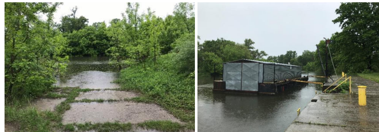
Obr. č. 17. a 18. Pohľad na jestvujúcu rampu a molo v obci Suchohrad.
