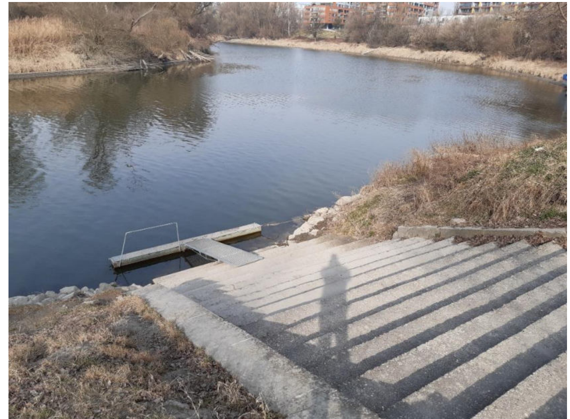
Obr.č.46. Nástupné schody a pontón vodáckeho klubu TATRAN v Karloveskom ramene.
